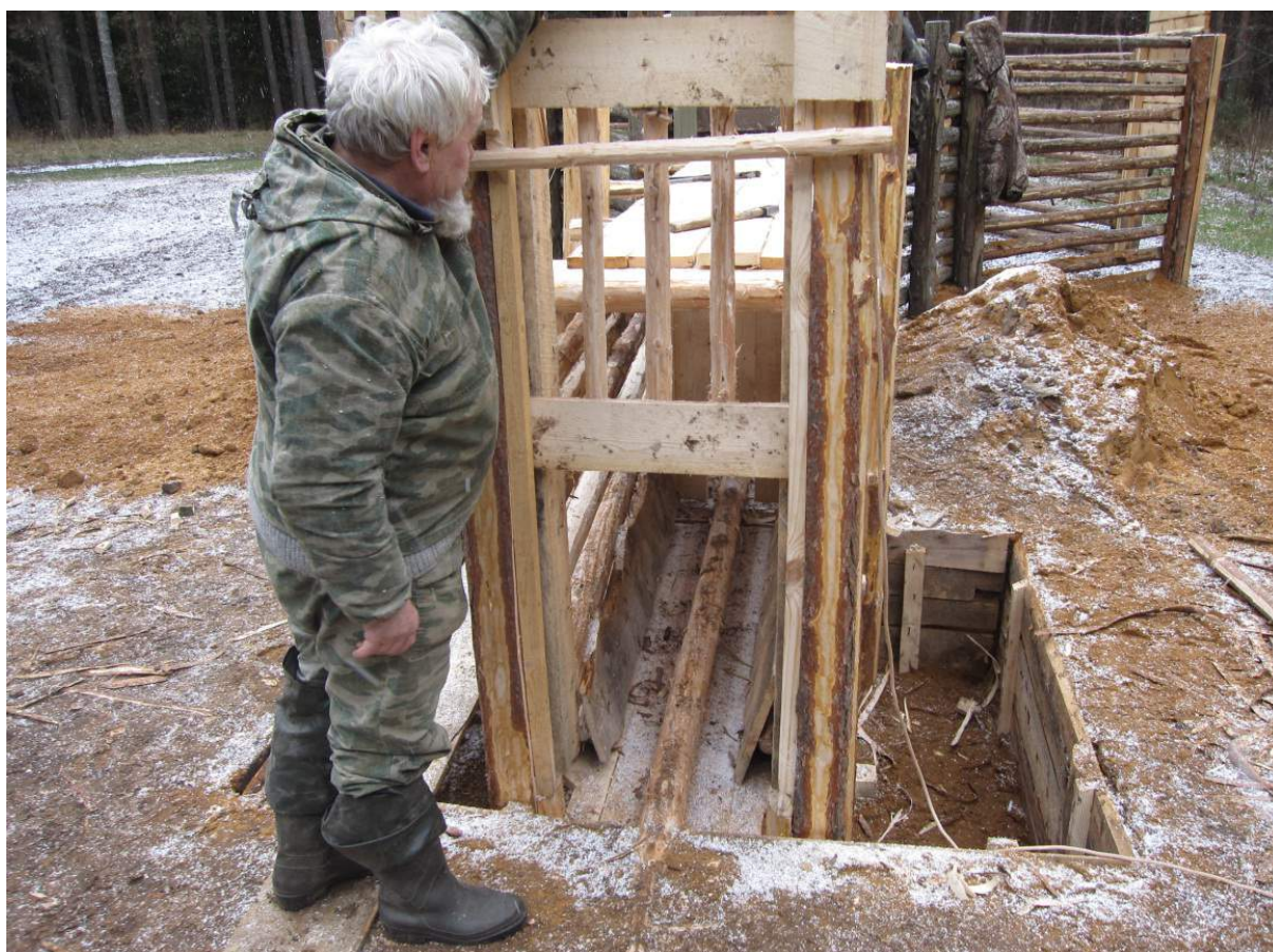
Рис. 8. Научно-техническое руководство специалистов ФГБУ «Центрохотконтроль» при строительстве «струнки».
